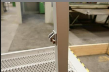
11. Desserrez les vis préfixées dans les poteaux et le rail supérieur
